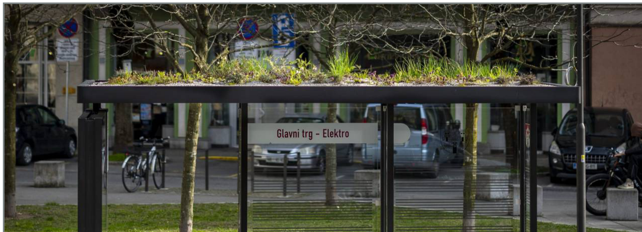
S5 I prenovljena avtobusna nadstrešnica
