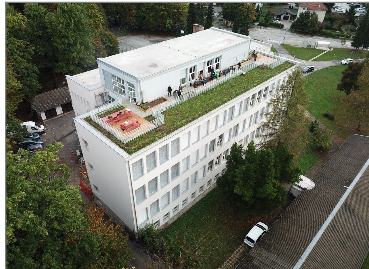
S12 | pogled na streho Osnovne šole Staneta Žagarja
